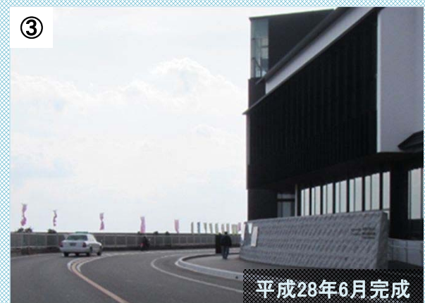
無電柱化(県道福山鞆線)
